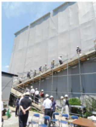
熊本市南区川尻にある国指定史跡「熊本藩川尻米蔵跡」の外城蔵(東蔵・西蔵)の保存修理工事は、昨年十二月から第一期工事が始まりました。工事は東蔵全体をシートで囲った後、柱などの骨格を取り除いた後、柱を残して屋根瓦や壁、床を取り外す解体を行い、瓦や木材の傷み具合や建築時期の特定が進められています。
